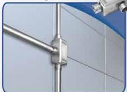
Acabamento limpo, sem parafusos na tampa
