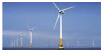
Caso: Ponte Eólica (Donghai -Shanghai)
