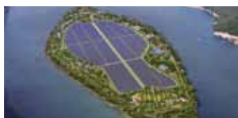
Caso: estação de energia fotovoltaica (Ilha de Crucian- Coreia do Sul)
