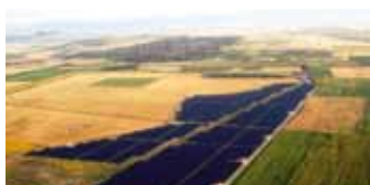
Caso: Estação de energia fotovoltaica (Bezmer-Bulgária)
