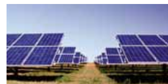
Caso: Estação de energia fotovoltaica (Carolina do norte-USA)
