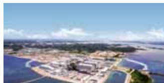
Casos: CGNPC projeto de estação de energia Nuclear (Yangjiang, fase II)
