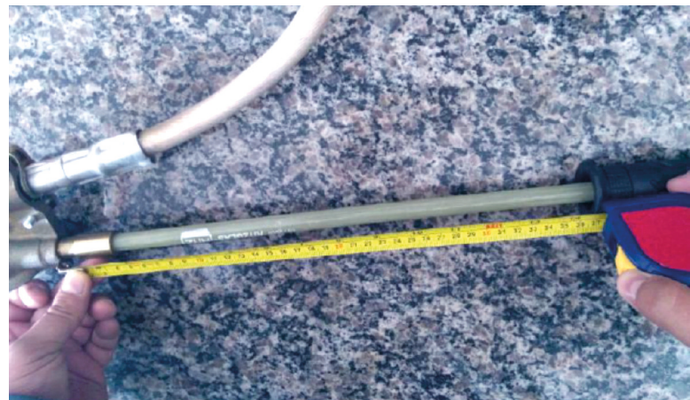
Fig 2- Medição de bastão de aterramento de painéis de baixa tensão para definição da distância de trabalho
