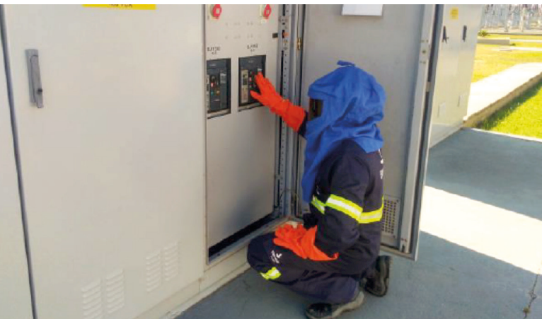
Fig 1- Simulação de manobra para definição da distância de trabalho padrão
