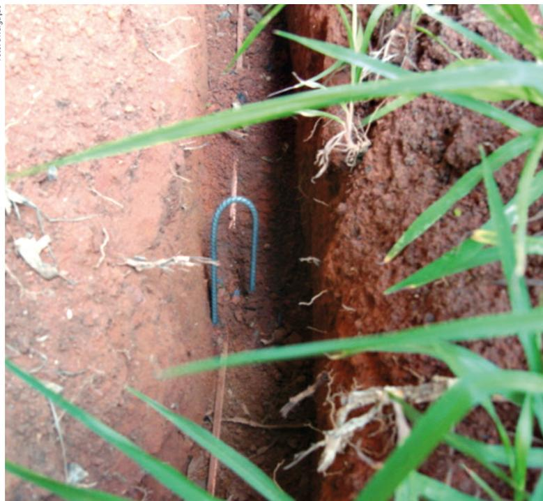
**Fig. 2 - Detalhe dos ganchos instalados no sistema de aterramento para dificultar o furto dos cabos.**
