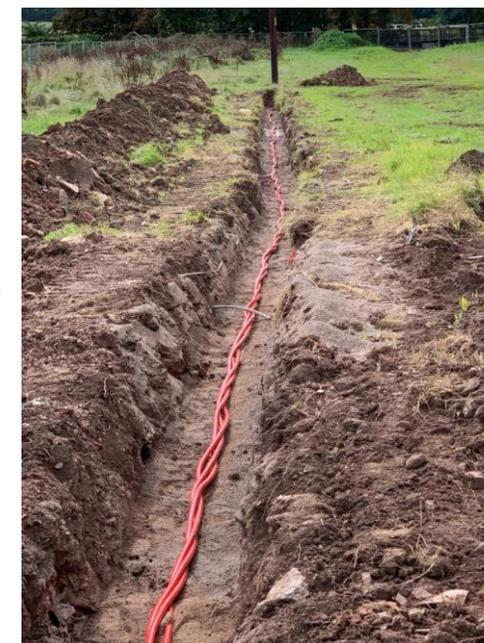
Resistividade térmica varia com tipo de solo, umidade, profundidade, temperatura do solo etc.
