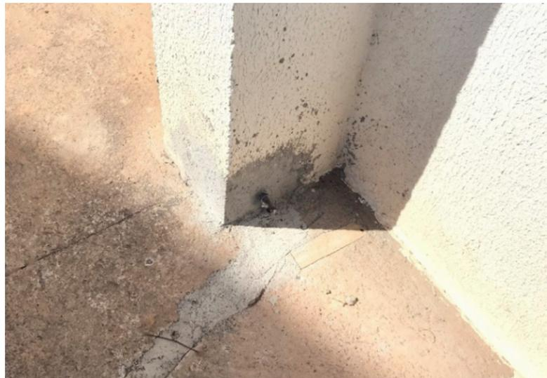
Foto 17: Conexão entre o eletrodo de aterramento e a fundação da estrutura
