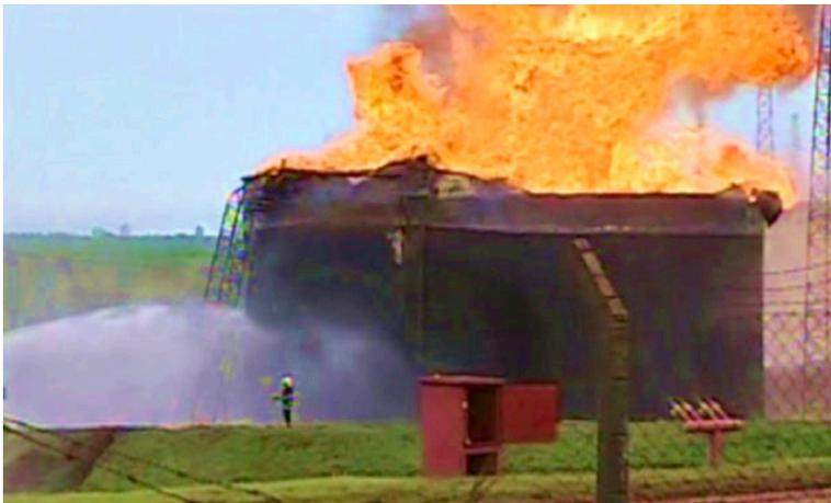
Figura 1 – Tanque de etanol em combustão após a incidência de uma descarga atmosférica.
