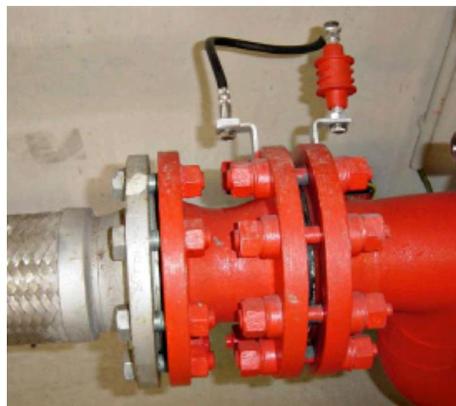
Figura 4: Centelhador de isolamento
