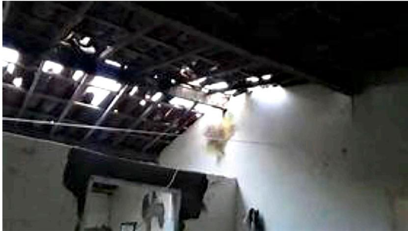
Figura 3: Destruição de telhado por descarga atmosférica (foto: internet)
