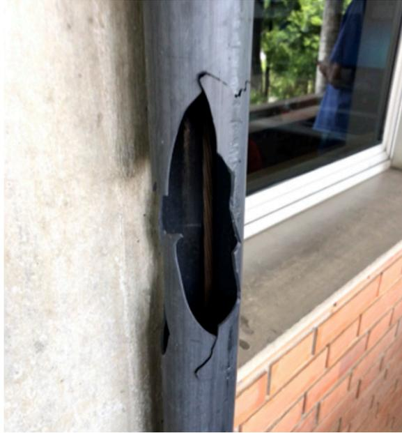
Figura 03: Tubulação de PVC quebrada
