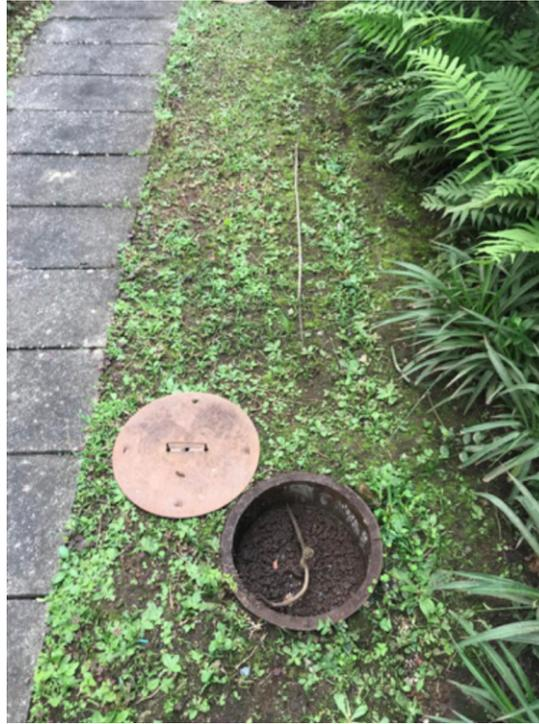
Figura 05: Cabos de aterramento instalado de forma errada (aparente)
