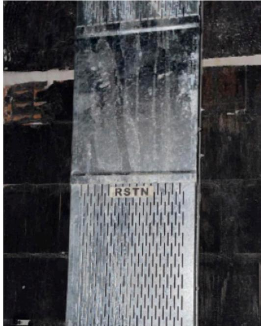
Figura 9 – Barramento grau de proteção IP-31 em shaft elétrico.
