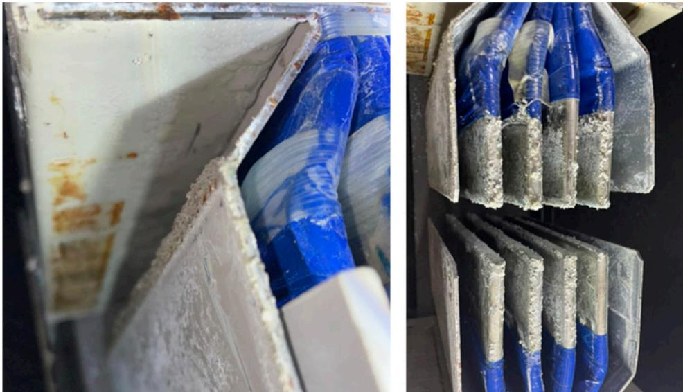
**Figura 8 – Barramento IP-55 afetado pelo empoçamento de água no shaft elétrico.**
