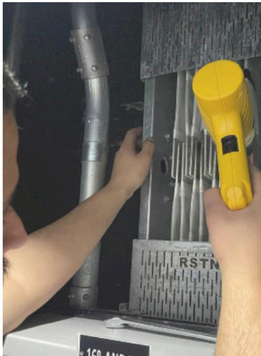
Figura 10 – Processo de secagem em barramento IP-31 com infiltração de água.
