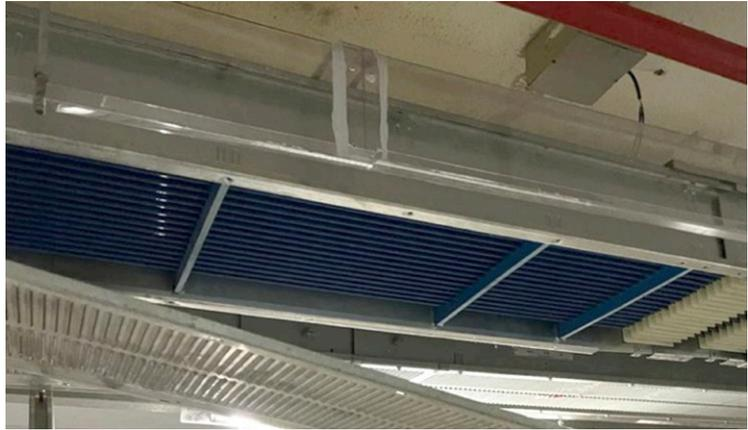
Figura 12 – Barramento IP-31 limpeza realizada in loco.
