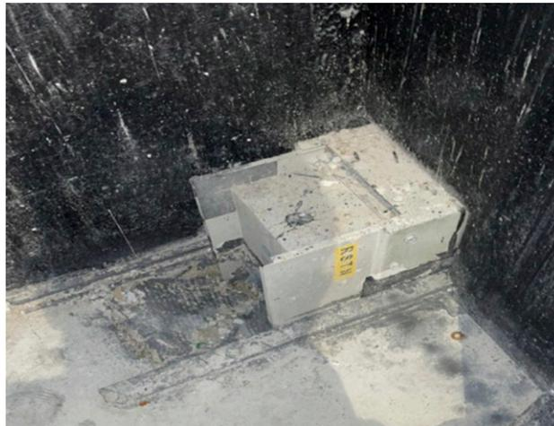
**Figura 3 – Barramento blindado desviando dentro do shaft de hidráulica para o de elétrica.**
