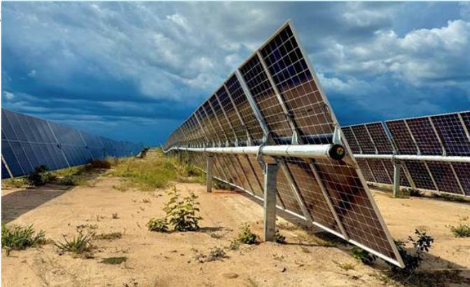
Por estar localizado no semiárido nordestino, o local de construção da usina solar apresentava desafios ambientais e de engenharia como solo rochoso e topografia irregular. Além disso, um dos requisitos para a construção da usina da EPC Elecnor era a preservação do solo superficial e da biodiversidade.
