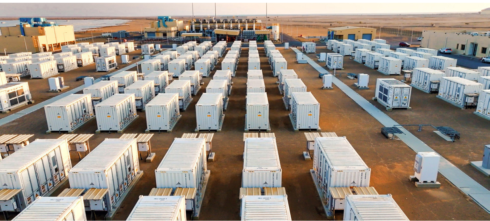
Projeto Red Sea, da Arábia Saudita, o maior projeto de armazenamento de energia em microrrede do mundo, com capacidade de armazenamento de 1.3GWh.
