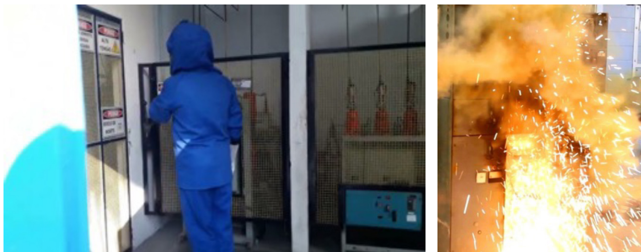
Fig 1- a) Manobra de disjuntor de média tensão e b) presença de arco elétrico
