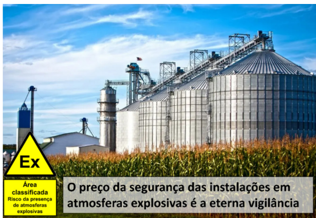
Instalações em atmosferas explosivas formadas por poeiras combustíveis, como indústrias siderúrgicas, mineradoras, portuárias, alimentícias ou do agronegócio
